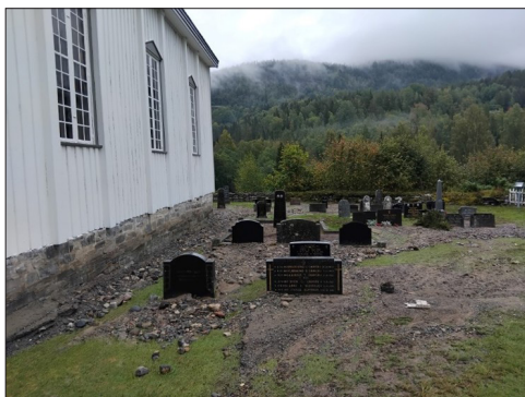
Flomskader på sydsiden av kirka.
