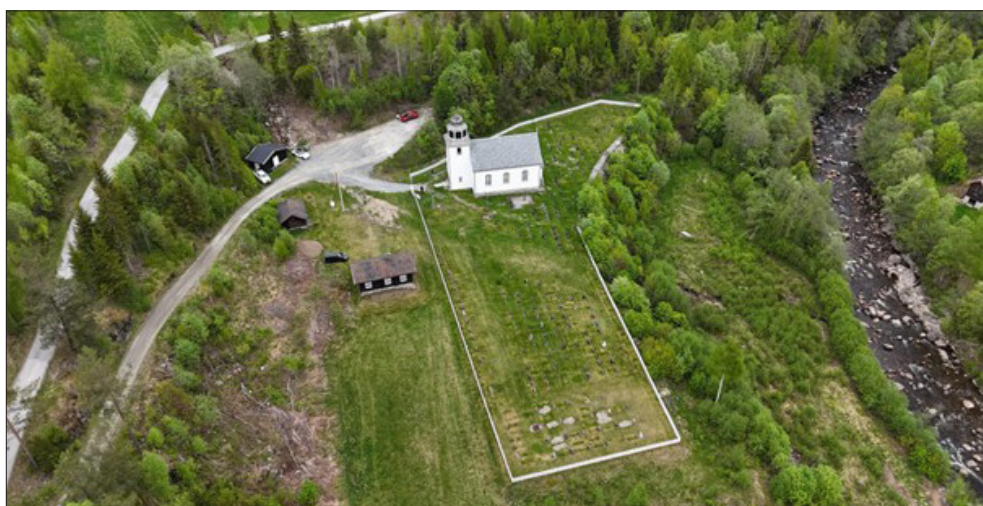
Hovin kirke etter at flomskadene er ryddet og utbedret.
